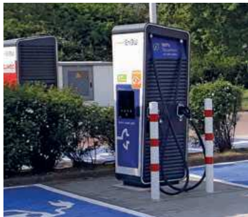
Poller schützen die Säule Quelle: SHP Ingenieure
