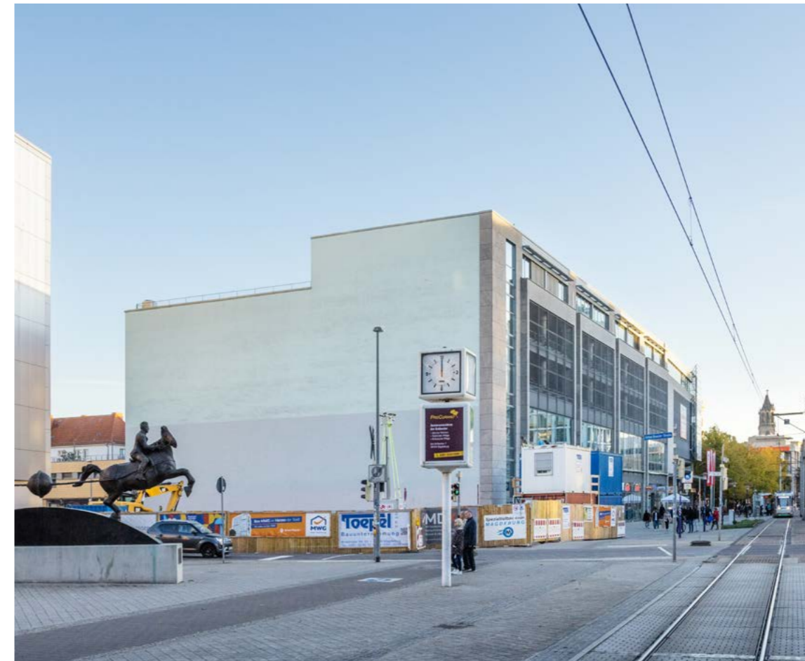
← Blick auf die Baulücke Julius-Bremer-Straße / Breiter Weg
