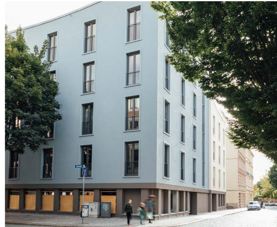
← 4-geschossige Eckbebauung Südstraße/Weststraße
