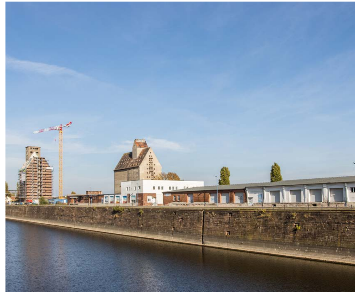
← Hafenbecken mit den historischen Lagerhallen und den Reichseinheitsspeichern im Hintergrund
