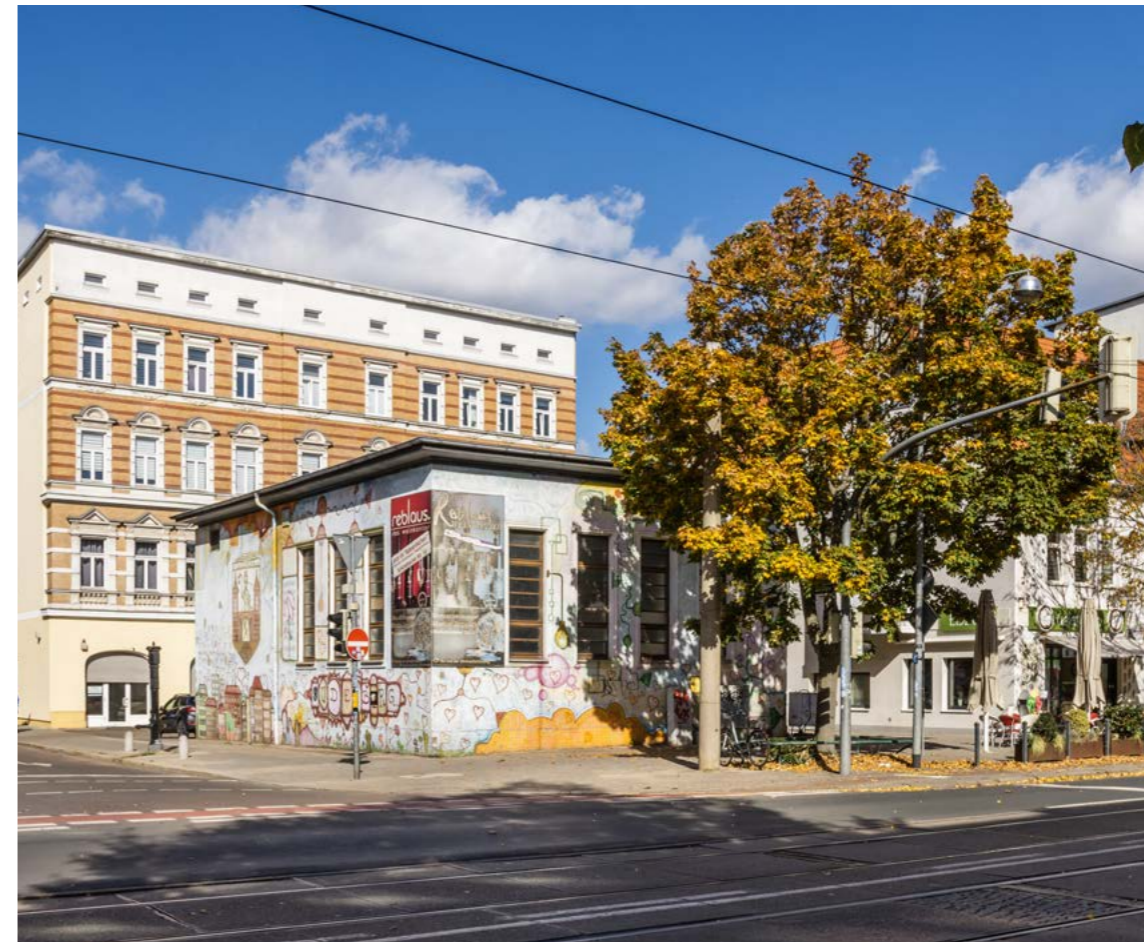
← Alte Trafostation auf dem Eiskellerplatz
