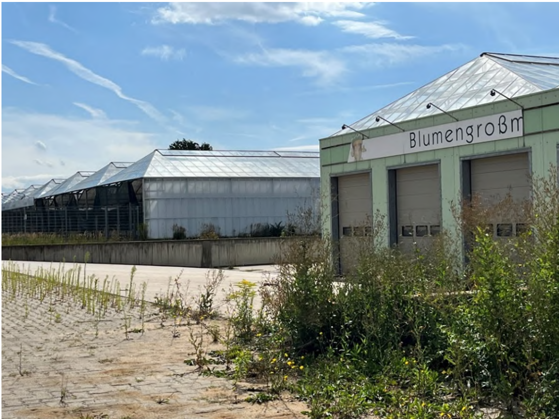
5 In Abbruch befindliche Gewerbebebauung (von Osten)
