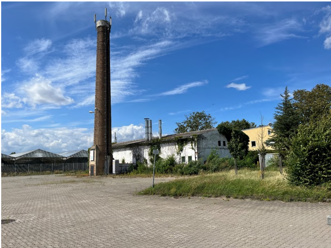
4 Wohnbebauung und ehemals genutzte Gewerbeanlage
