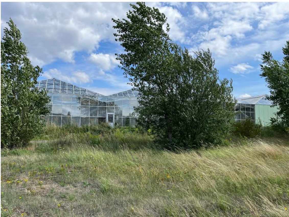
6 In Abbruch befindliche Gewerbebebauung (von Westen)
