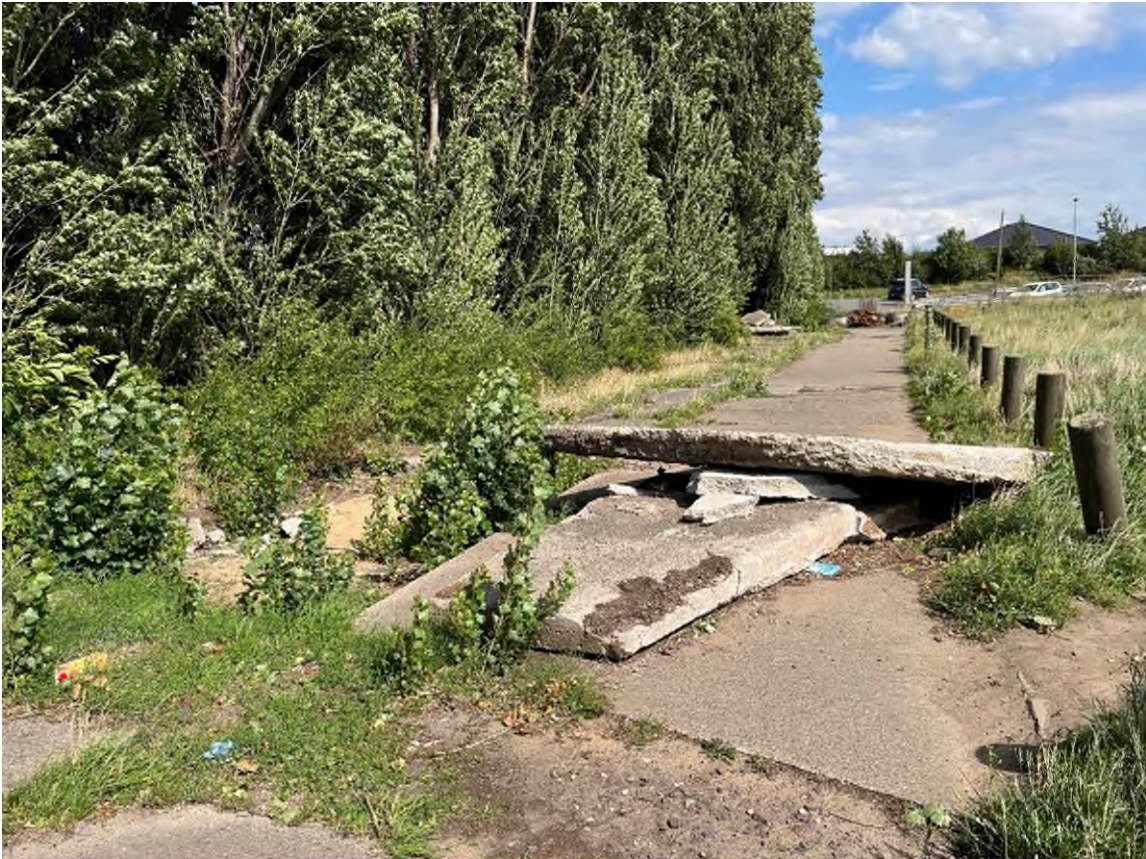
2 Blick in den Fußweg zur Straße "Kümmelsberg"
