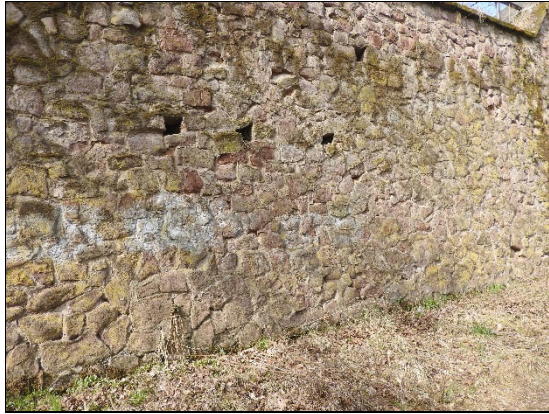
Abb. 5 a & b: Ein bereits sanierter Mauerabschnitt der Festungsanlage mit darin als Brutplatz für Vögel belassenen Nischen. (26.03. & 12.04.2018).
