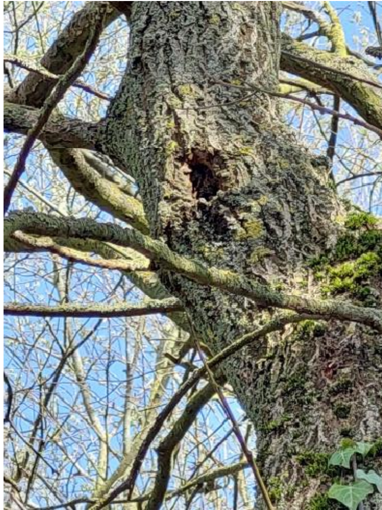
Foto 9: Öffnung an einem Stammriss in etwa 6-7 m Höhe – vom Boden nicht zu erkunden
