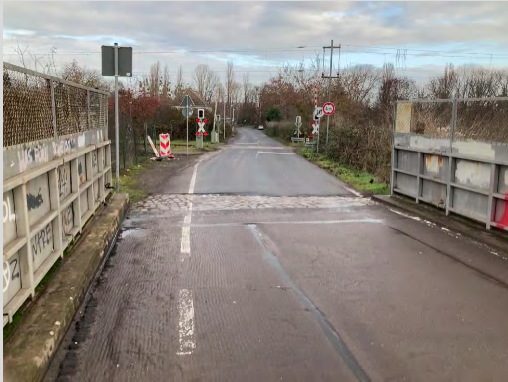
Foto 05 – Lüttgen-Salbker Weg, Blickrichtung Ost von Brücke über DB-Anlagen auf benachbarten Bahnübergang © IBB
