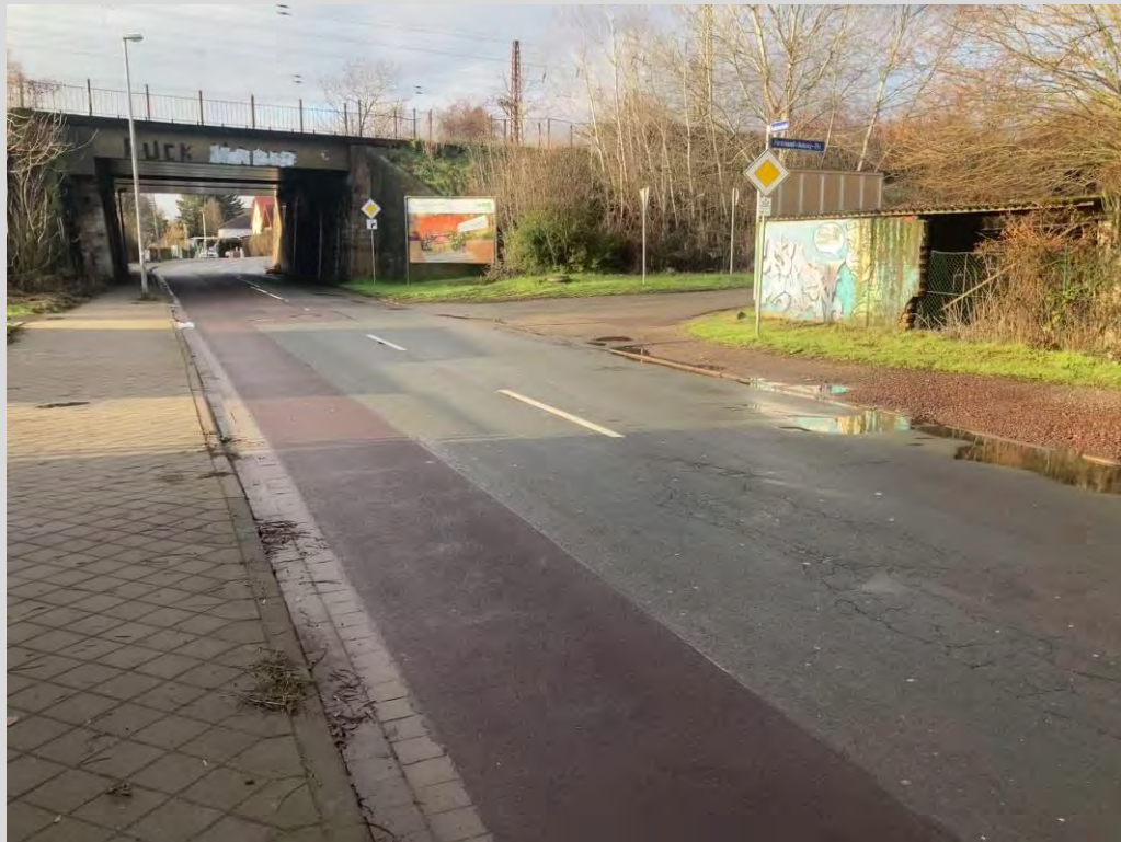
Foto 03 – Faulmannstraße mit Einmündung Ferdinand-Schrey-Straße und Unterführung unter den Bahnanlagen © IBB
