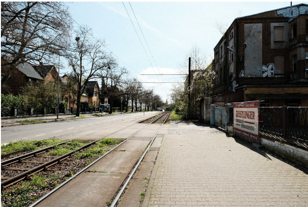
Abbildung 2: Straßenbahnhaltestelle Turmstraße ohne Querungsmöglichkeit (Quelle: eigene Aufnahme)
