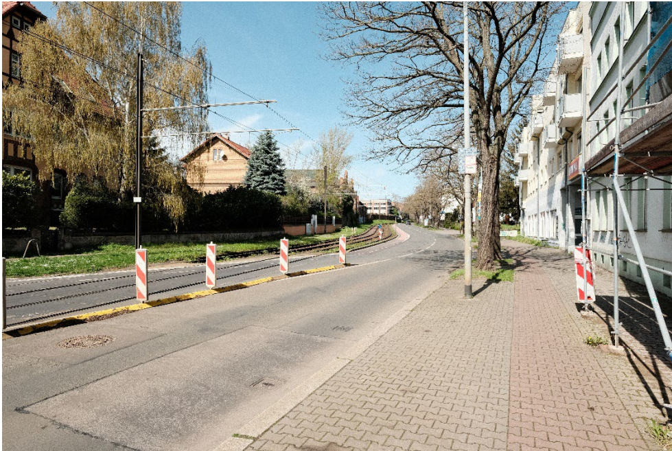
Abbildung 5: Radverkehrsanlagen im Bestand, Radfahrstreifen stadtauswärts und getrennter Geh-/Radweg ohne Benutzungspflicht (rechts) stadteinwärts (Quelle: eigene Aufnahme)
