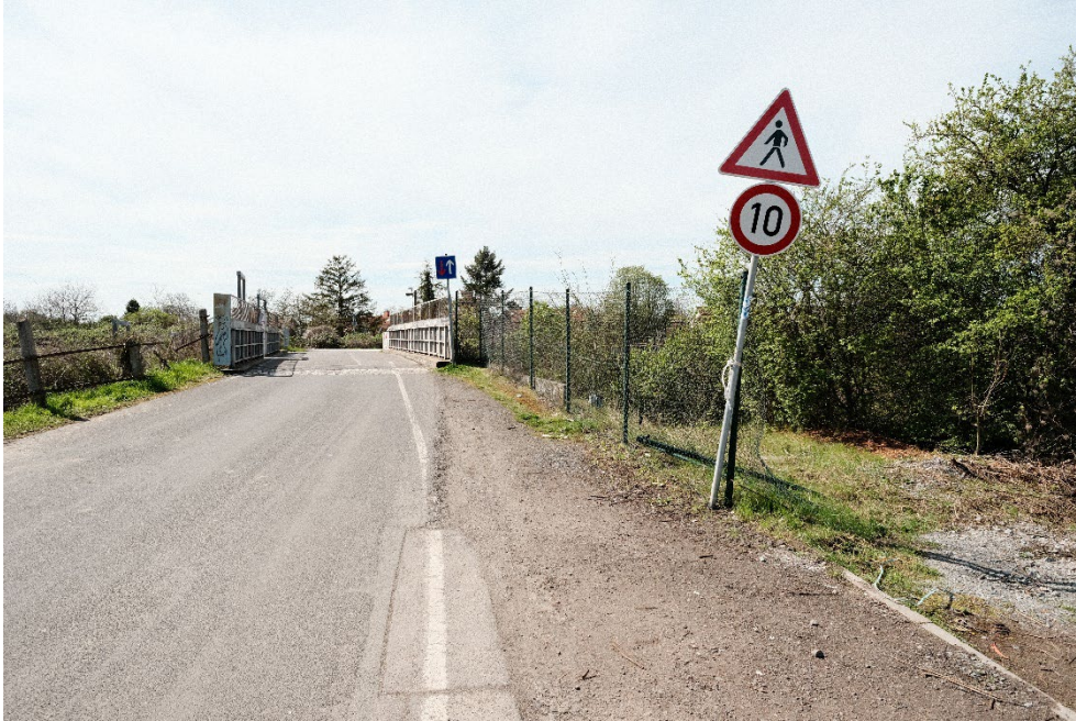
Abbildung 6: Fehlende Fußverkehrsanlagen an der S-Bahn-Station Magdeburg-Salbke
