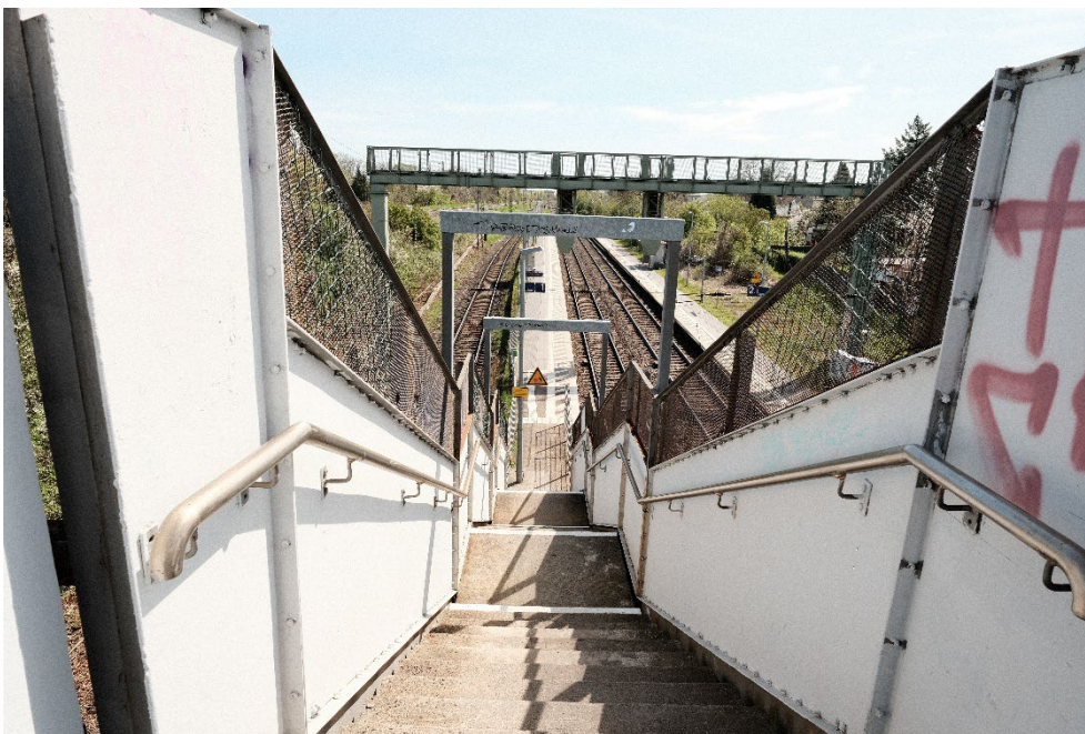
Abbildung 3: Zugang S-Bahnhaltestelle Magdeburg Salbke (Quelle: Eigene Aufnahme)
