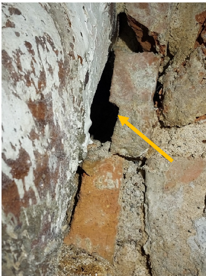
Foto 8: Fundstelle der Fransenfledermaus im Keller des Gebäudeteils 7.2
