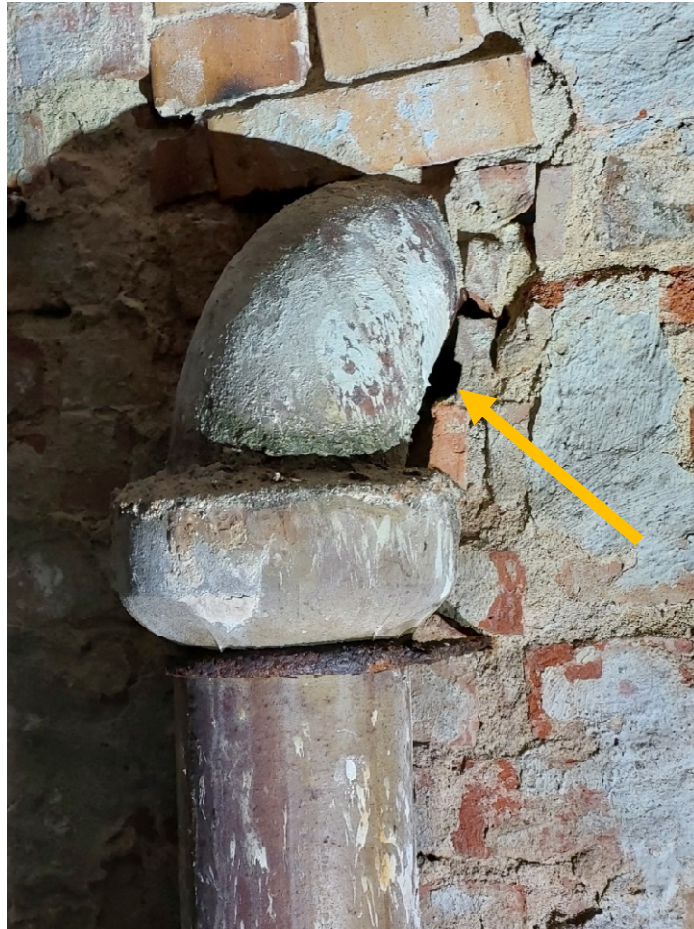
Foto 7: Fundstelle der Fransenfledermaus im Keller des Gebäudeteils 7.2
