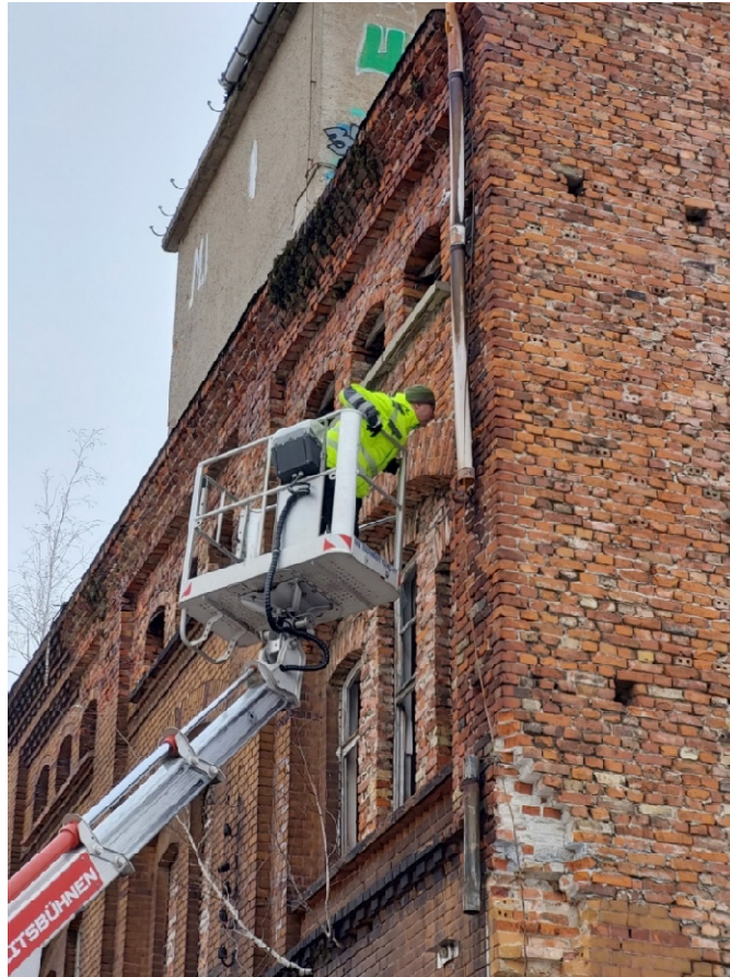
Abbildung 4: Untersuchung der Außenfassade von Gebäudeteil 5.5
