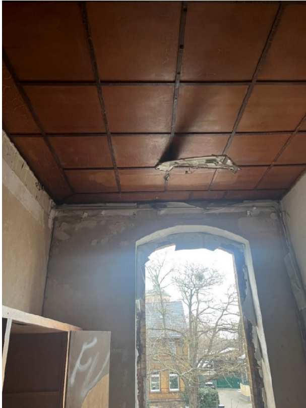
Foto 1: Deckenvertäfelung in Gebäudeteil 5.3 mit darüber vorhandenem Hohlraum
