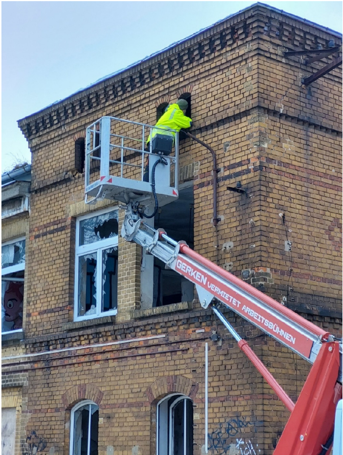
Foto 11: Kontrolle des nicht zugänglichen Dachspeichers des Gebäudeteils 6.2
