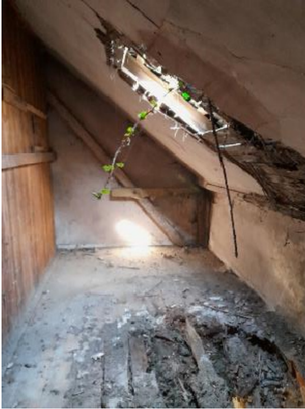
Foto 3: Blick in einen Raum im Dachgeschoss
