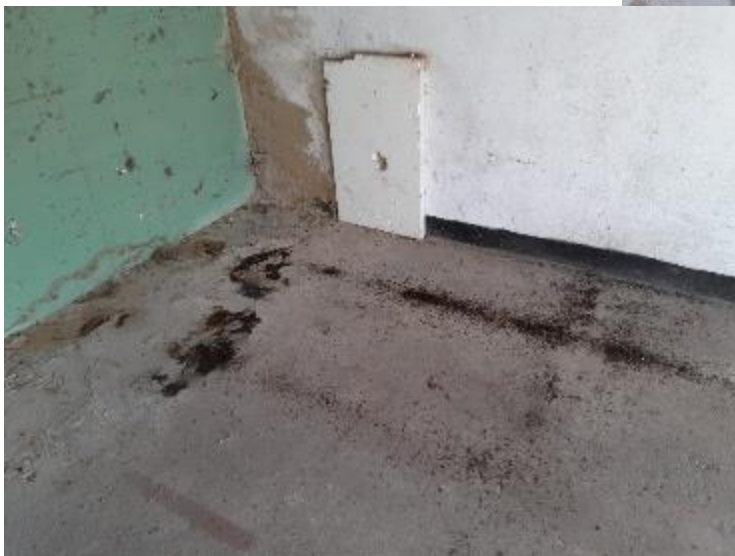
Foto 12: Blick auf den Fußboden in Garage 3
