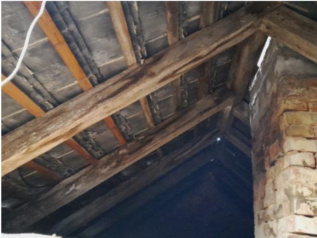
Foto 4: Blick in den Dachfirst
