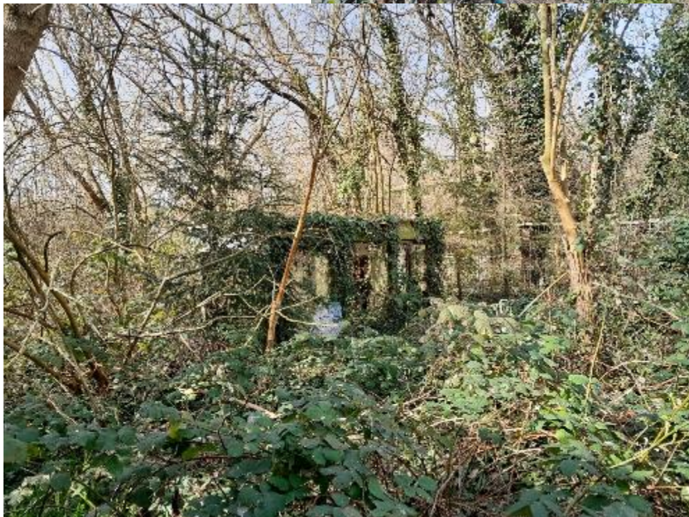
Foto 38: Blick auf die Rudimente eines Gartenhäuschens an der nordöstlichen Grundstücksgrenze
