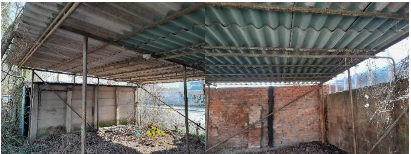
Foto 46+47: Blick in den Carport
