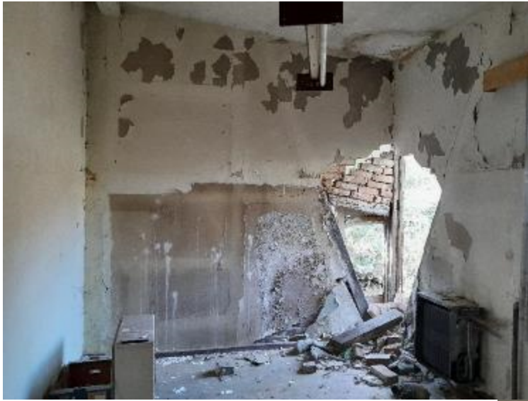
Foto 16+17+ 18: Blick in den Schuppen
