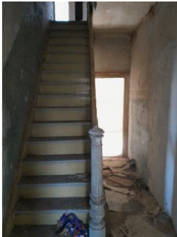
Foto 6: Blick in den Flur Erdgeschoss mit Treppe
