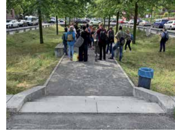
Abb.73: Beispiel - Schwammstadt: Niederschlagsversickerung benachbarter Verkehrsflächen in öffentlichen Grünflächen, Berlin-Rummelsburg ↗
