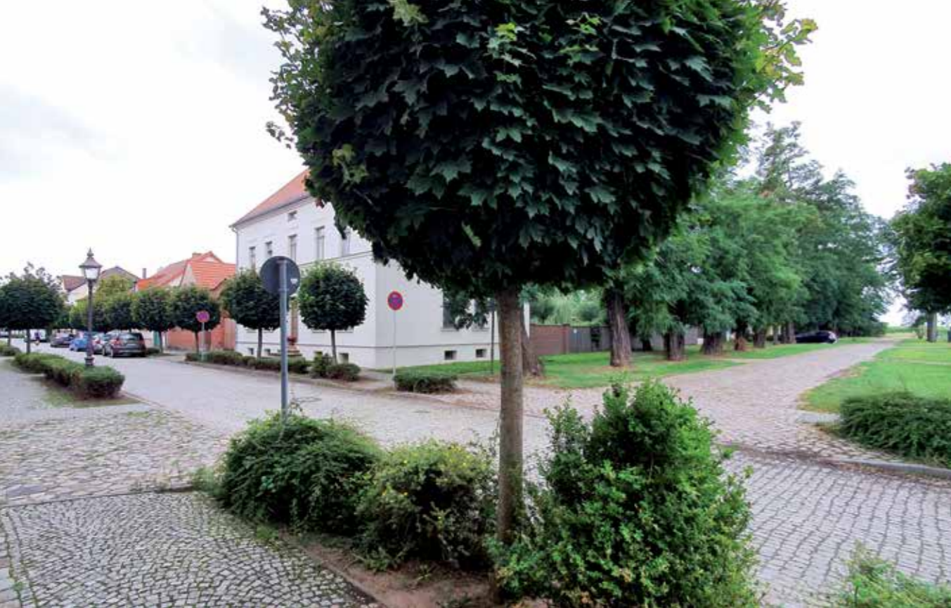
Abb.5: teilentsiegelte Straße in Gnadau ↗
