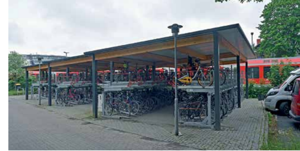
Abb.85: Beispiel – Radstation am S-Bahn-Endpunkt Wedel
