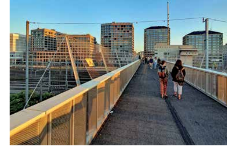
Abb.88: Beispiel - Fußgängerbrücke über Gleisanlagen, Zürich ↗
