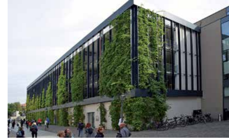
Abb.74: Beispiel - Vertikalbegrünung: Parkhaus, Lutherstadt Wittenberg ↗
