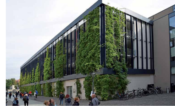
Abb.74: Beispiel - Vertikalbegrünung: Parkhaus, Lutherstadt Wittenberg ↑
