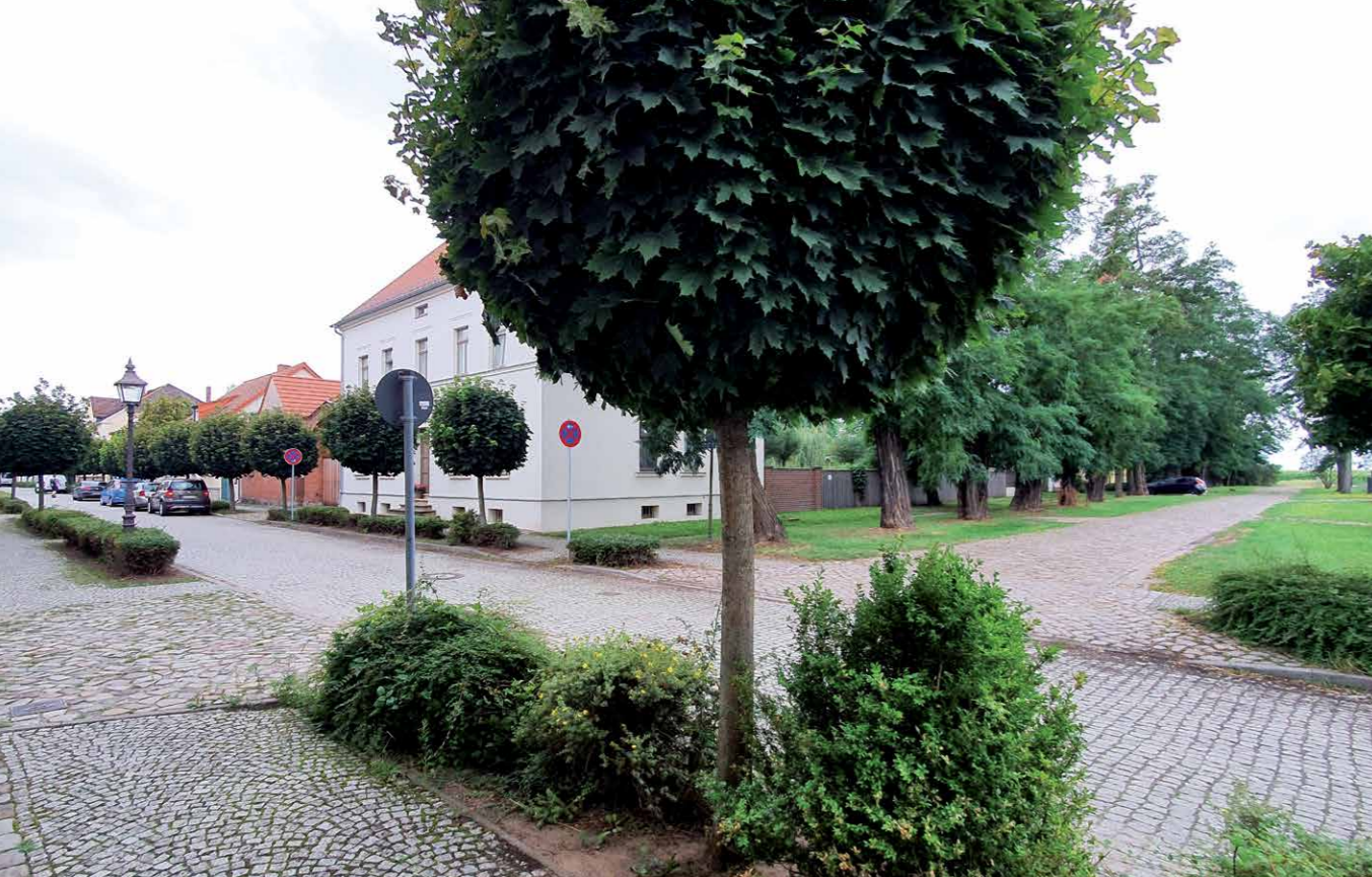
Abb.5: teilentsiegelte Straße in Gnadau
