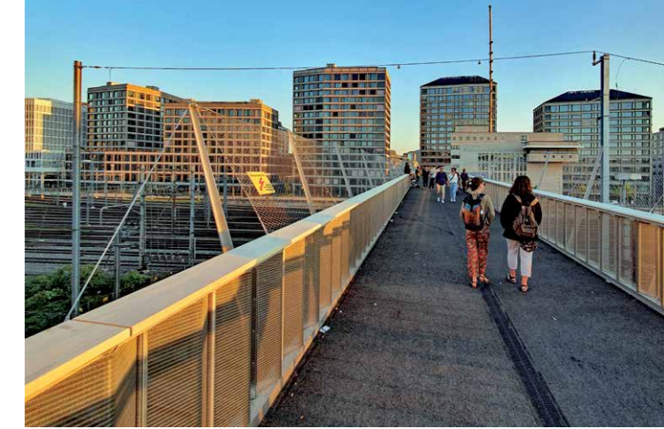
Abb.88: Beispiel - Fußgängerbrücke über Gleisanlagen, Zürich
